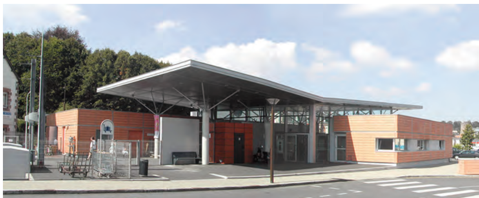
Lannion (22). Gare multimodale routière et SNCF 580 m²/ 915 000 €HT Livraison 2000 Ville de Lannion et SNCF
