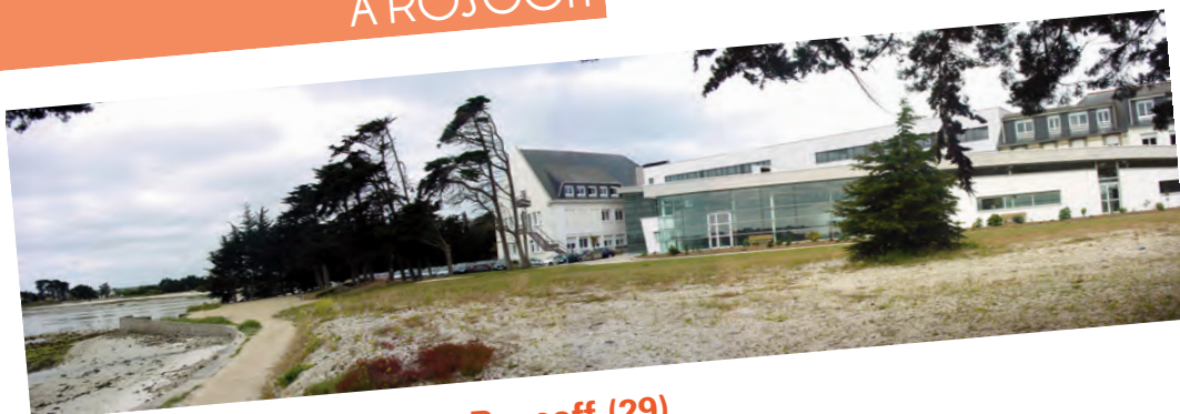
Roscoff (29). Centre de rééducation 2 ème phase Restructuration des services 4 000 m 2 / 6 300 000 €HT Livraison 2007 Centre de Perharidy
