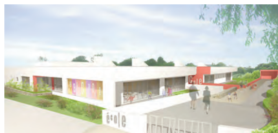
Louannec (22). Ecole maternelle 1 003 m 2 / 1 320 000 € HT Chantier en cours Commune de Louannec
