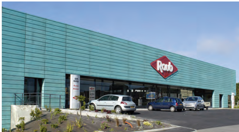
Lannion (22). Extension de l'entreprise Raub 1 800 m 2 / 1 900 000 € HT Livraison 2006 Raub
